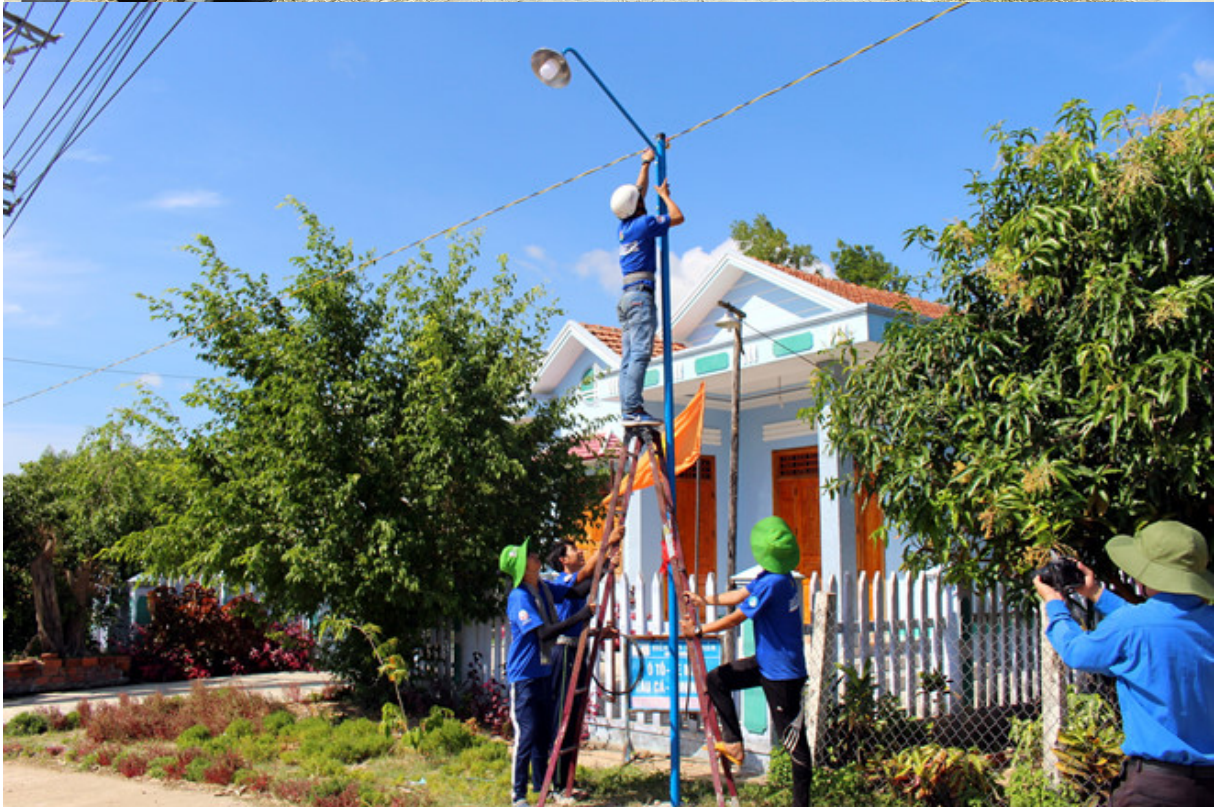
Công trình lắp đặt đèn đường quê nông thôn tự động điều khiển
